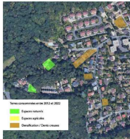
Figure 4: Logements individuels construits dans le bois des Rames (consommation de 0,11 ha) (source : tome 2, p. 75)
